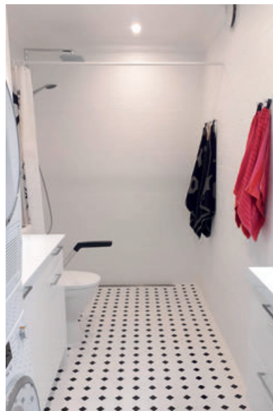
Pitkänomaisen kylpyhuoneen etualalla on vasemmalla vaatehuollontilat ja oikealla allaskaluste ja peilikaappi. Takaosassa on tukikahvallinen wc-istuin ja sen vieressä linjalattiakaivollinen suihku.
