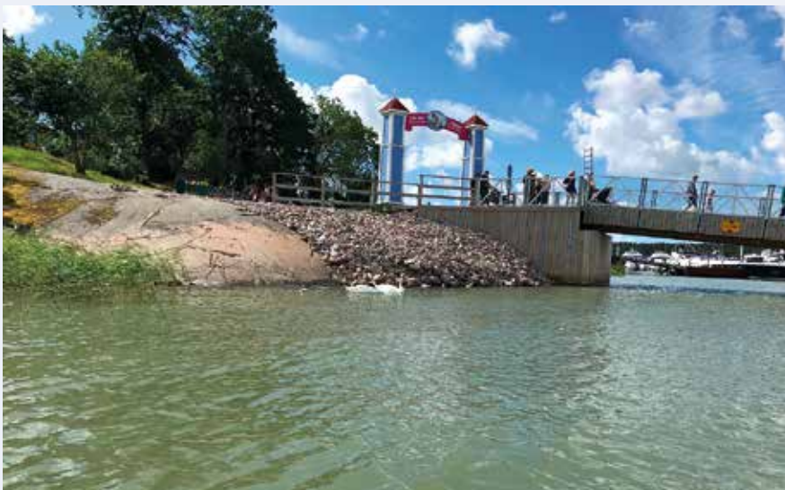
Muumimaaailmaan johtavan sillan ali mahtuu soutuveneellä.
