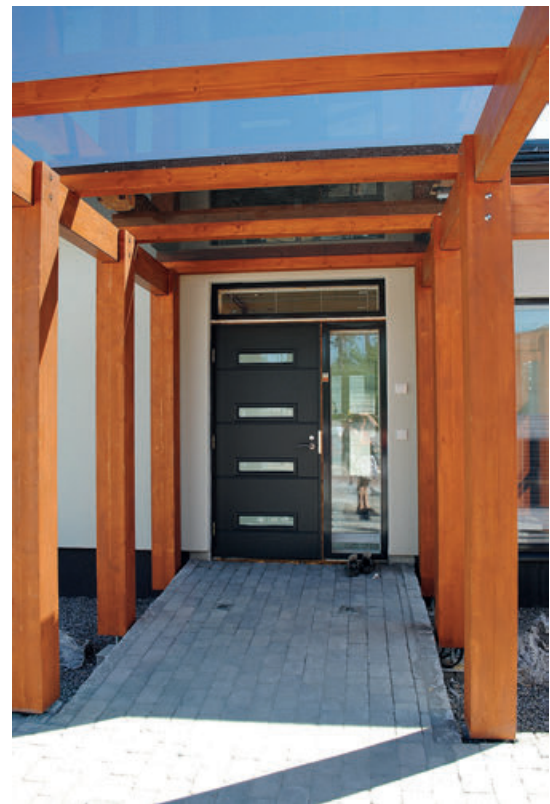
Toimivan sisääntulon kaksi tärkeää: esteetön sisäänkäynti katoksessa ja lämmitettävä luiska.
